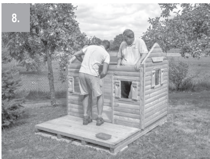
8. Anschließend die Wandelemente ausrichten und mit Schrauben 5 x 80 mm (15) mit dem Boden verschrauben (Seitenwände mit jeweils 3 Schrauben und Tür- und Rückwand mit jeweils 4 Schrauben).
