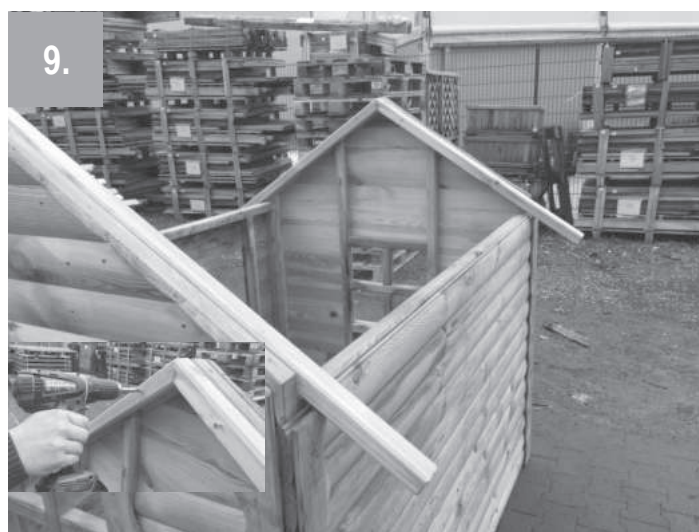
9. Jeweils 2 Dachunterzug-Balken (8) pro Seite mit je 2 Schrauben 5 x 70 mm (14) an den Seitenwänden (3, 4) verschrauben (siehe Abbildung).
