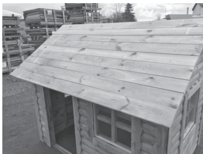
2.) Das gerade Dach (geeignet für Dachpappe)
